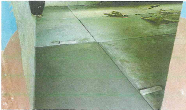
Foto 3: Entordecido de concreto en modulo de aula
