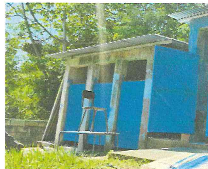
Foto 6: Techado en modulo de baños
