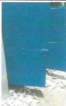
Foto 5: Puerta en modulo de baños
